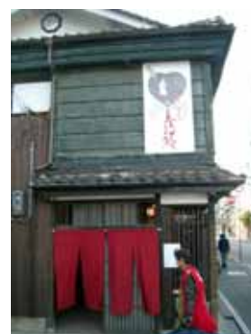
観光施設として生まれ変わった鳳翔館。
