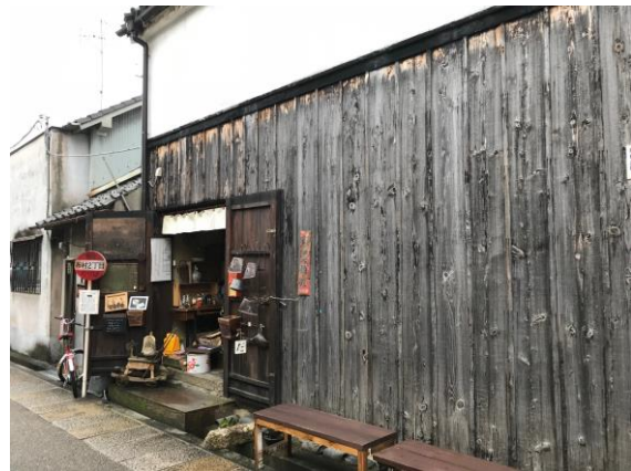
空きスペースを活用した店舗
