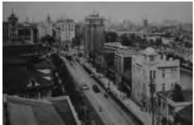
土佐堀通り(北浜)を東から西に見た近代の風景 通り沿いには近代建築が並ぶ
