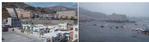
震災前の女川町立病院と津波により水没した様子
